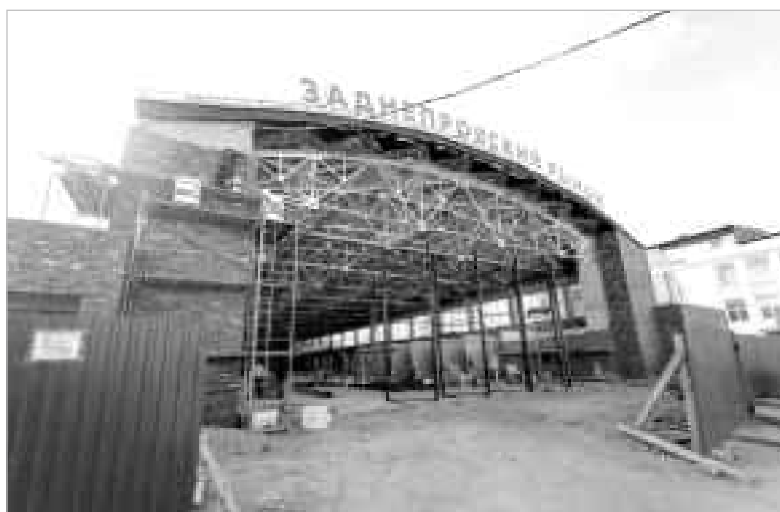
Здание Заднепровского рынка капитально отремонтируют.
