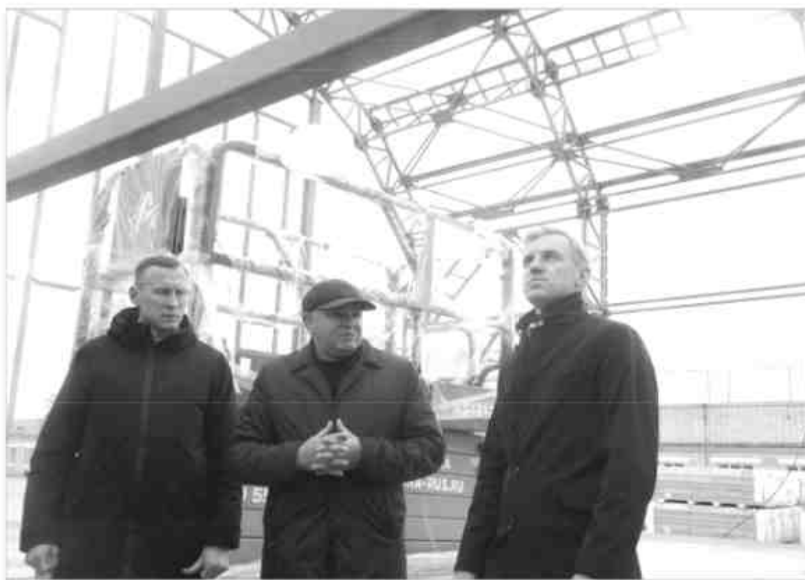
В. Анохин побывал на стройплощадке нового бассейна в Вязьме.
