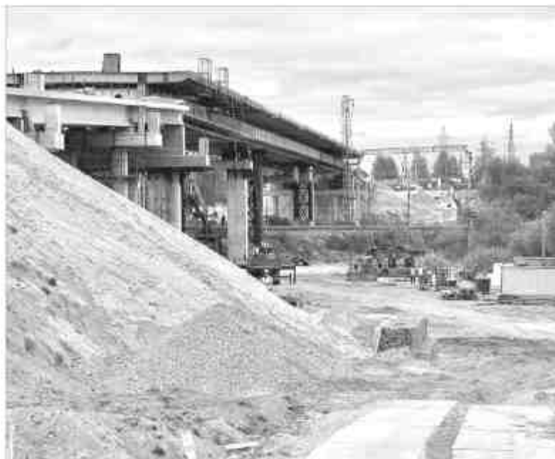
Готовность нового путепровода в Вязьме почти 80%.
