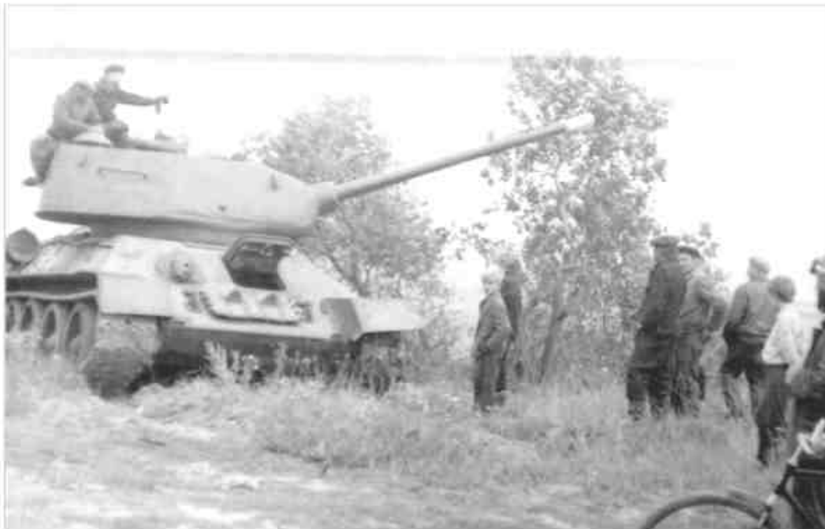
Подготовка к установке боевой машины.
