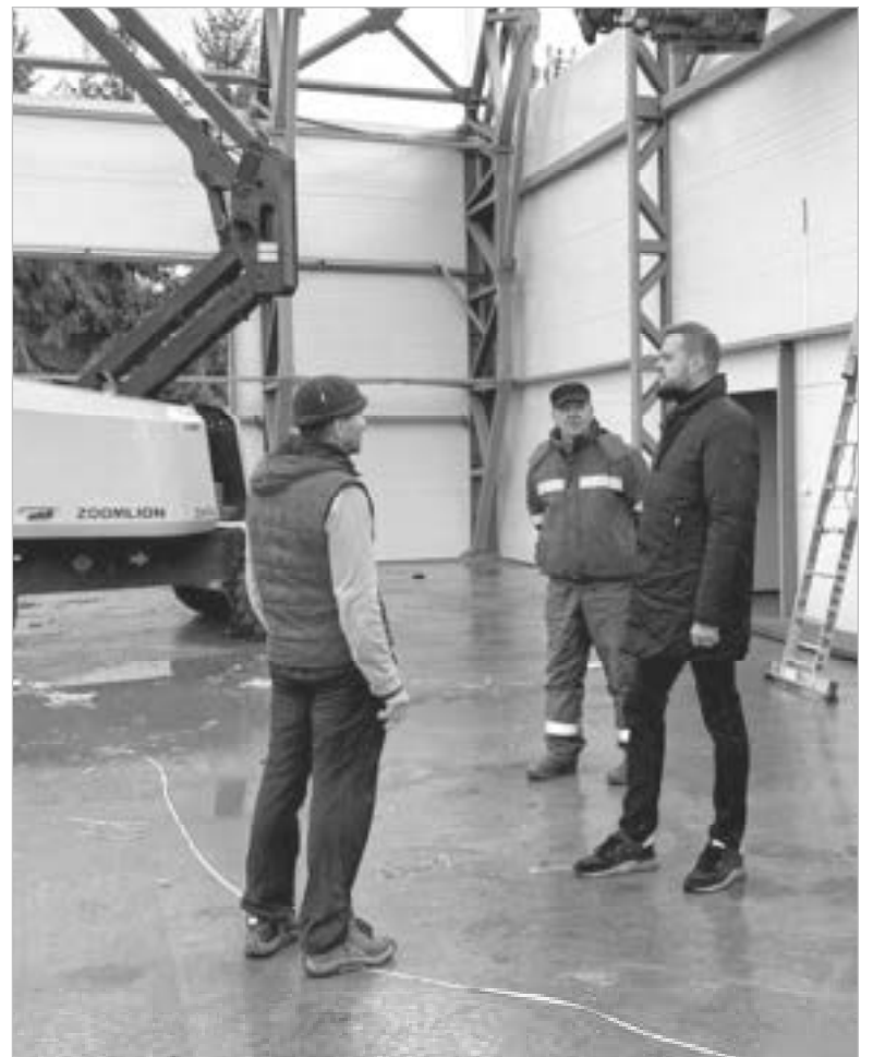
А.Туров с представителями подрядчика осматривает строительную площадку нового ФОКа.
